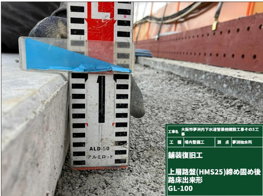
写真タイトル: 舗装復旧工
